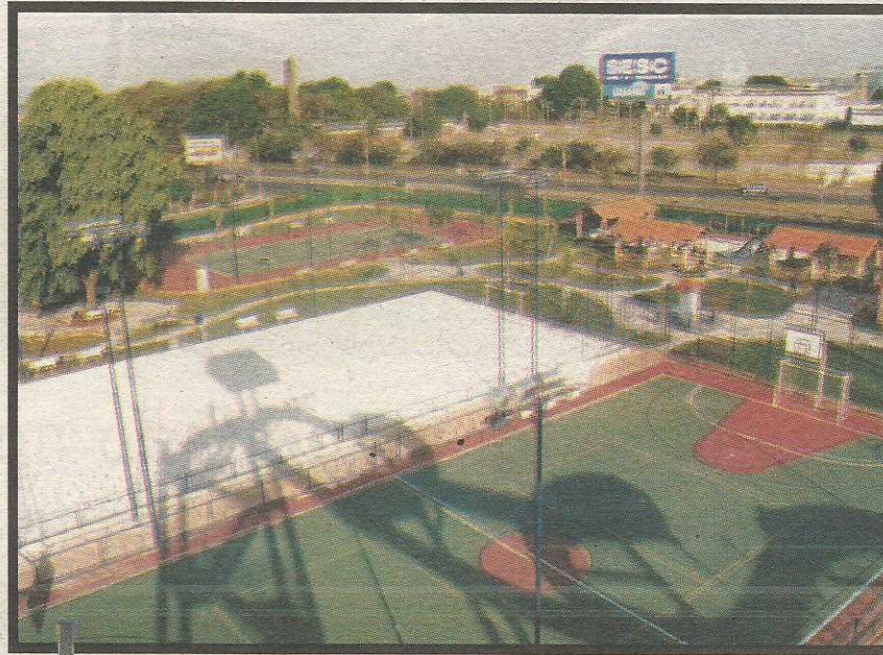
Clube, localizado no centro do Guará I, vai receber melhoras significativas
