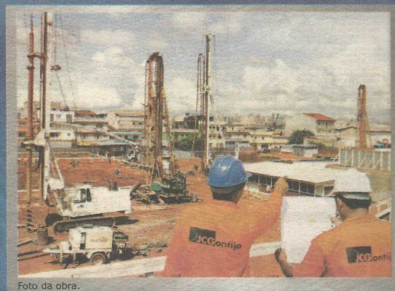
Foto da obra.
