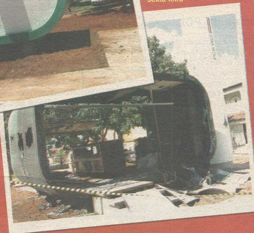
Novo módulo foi instalado nesta sexta-feira
