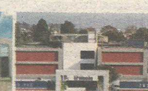
P6 - COLÉGIO PROJEÇÃO UNIDADE GUARÁ
