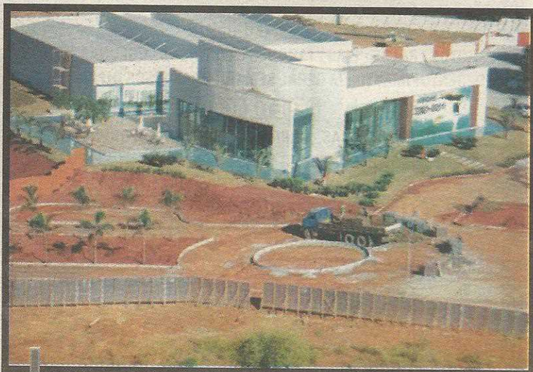
As obras estão em ritmo acelerado. A previsão de entrega é para o início de 2011
