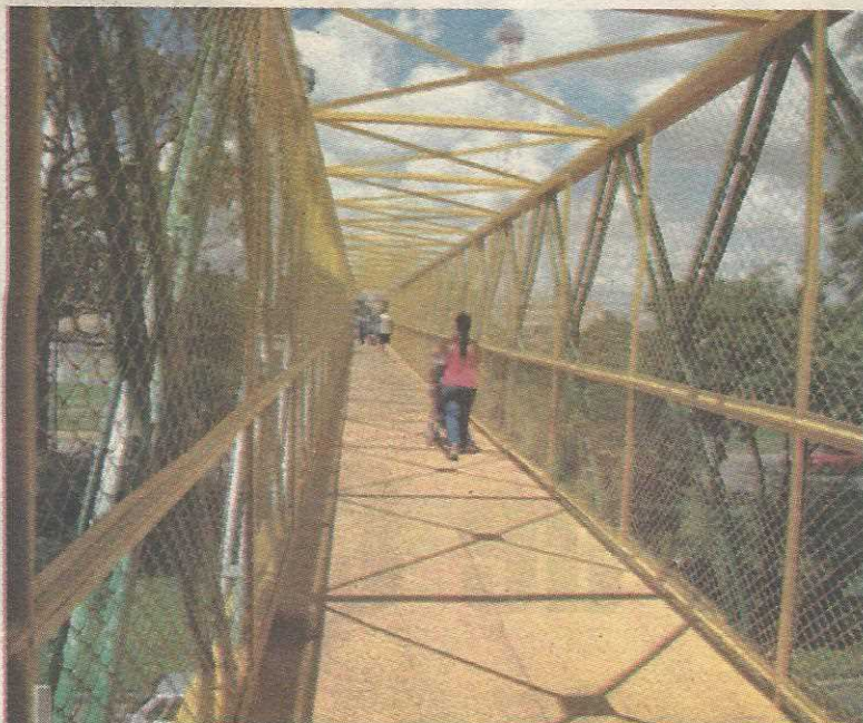
Todas as passarelas da EPTG estão sendo reformadas
