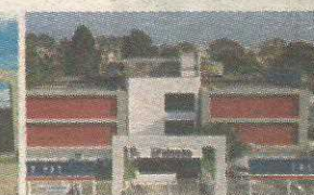
P6 - COLÉGIO PROJEÇÃO UNIDADE GUARÁ
