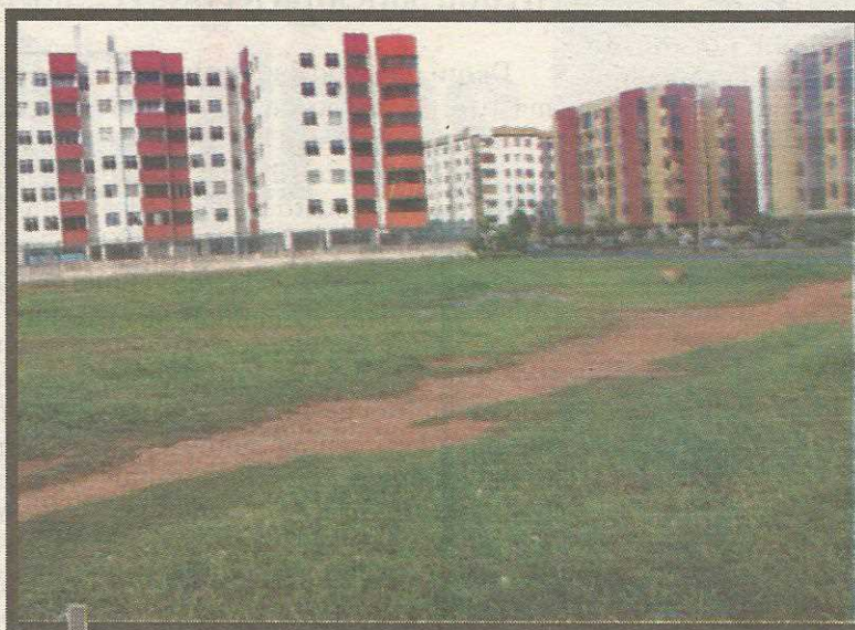
Projeções licitadas estão localizadas entre as QIs 27 e 31
