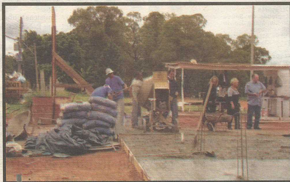
Obras já começaram e devem ser concluídas em dois meses
