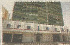
P3 - FACULDADE PROJEÇÃO NÚCLEO DE PRÁTICA JURÍDICA E LABORATÓRIOS DE COMUNICAÇÃO SOCIAL TAGUATINGA
