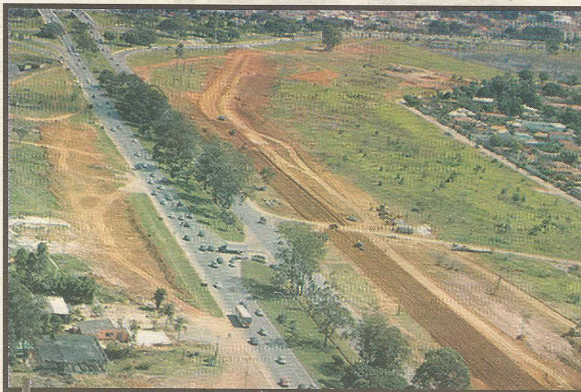
Durante as obras pista será reduzida. Motoristas devem evitar saída pelo Guará I
