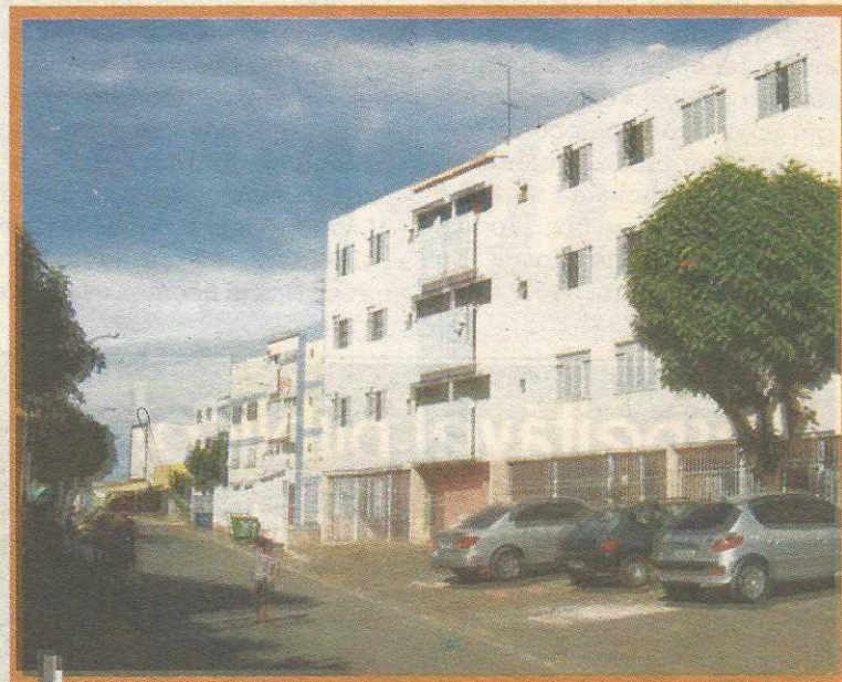
Da parte antiga, ainda existem os prédios originais, embora todos reformados e sem os banheiros coletivos
