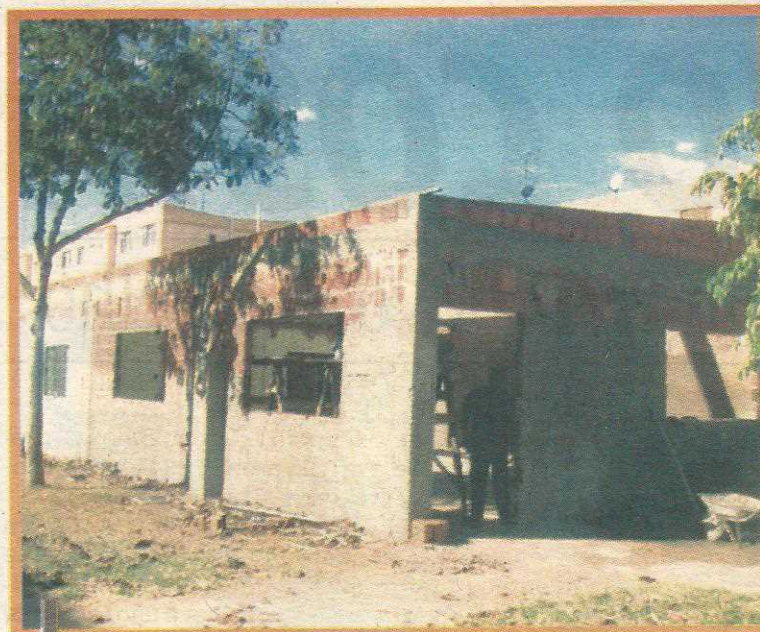
O prédio antigo do CCI está sendo substituído por um novo
