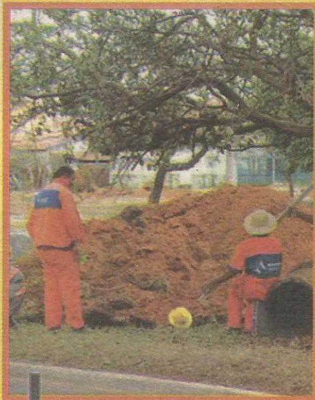
Obras previnem contra os alagamentos no período das chuvas
