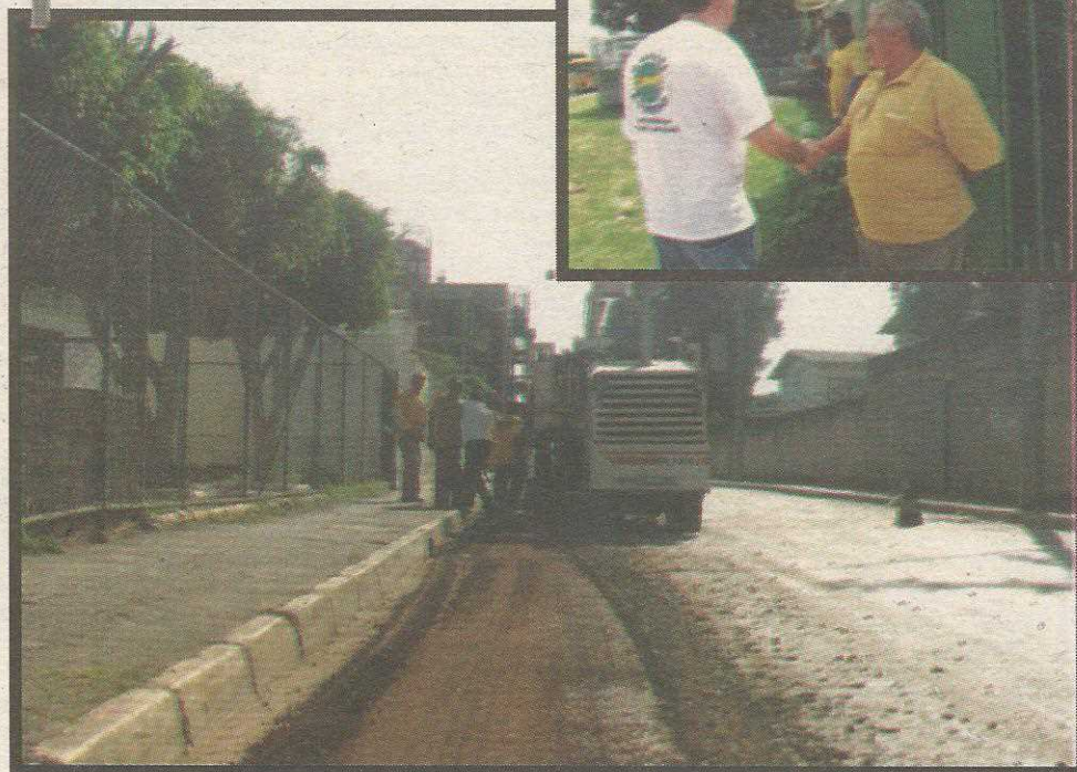
Recapeamento em andamento. Administrador Joel ouve os moradores das quadras
