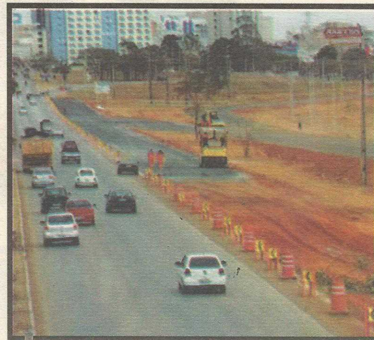
As obras ao lado da quadra Lúcio Costa estão bem adiantadas
