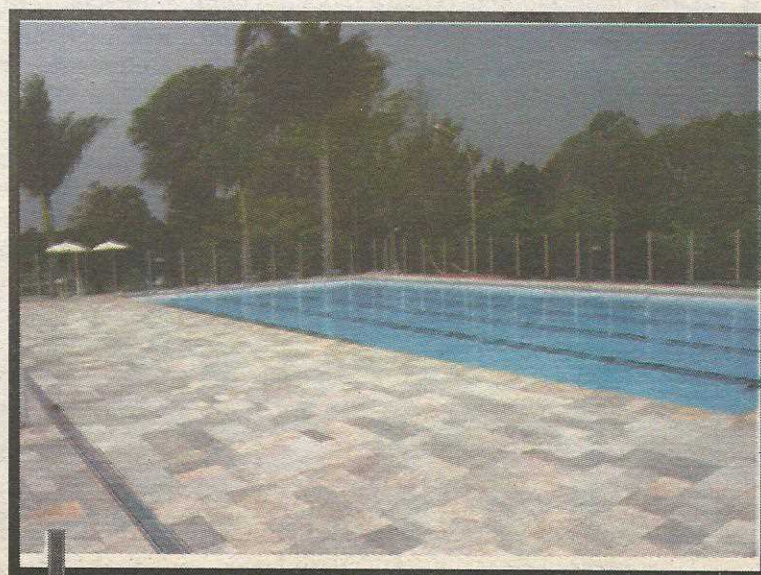
Instalações do Clube do Sesi serão reaproveitadas
