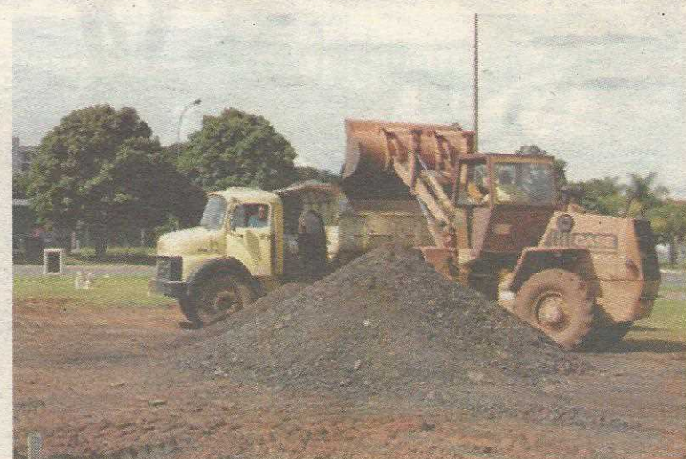
Depois de triturado, asfalto é reutilizado
