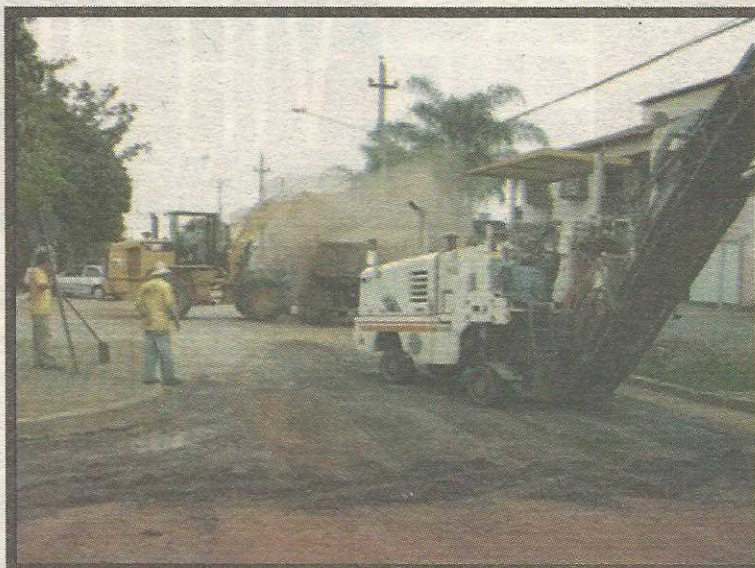
Asfalto antigo está sendo removido para dar lugar a outro. Recuperação de todo o Guará II está pronta
