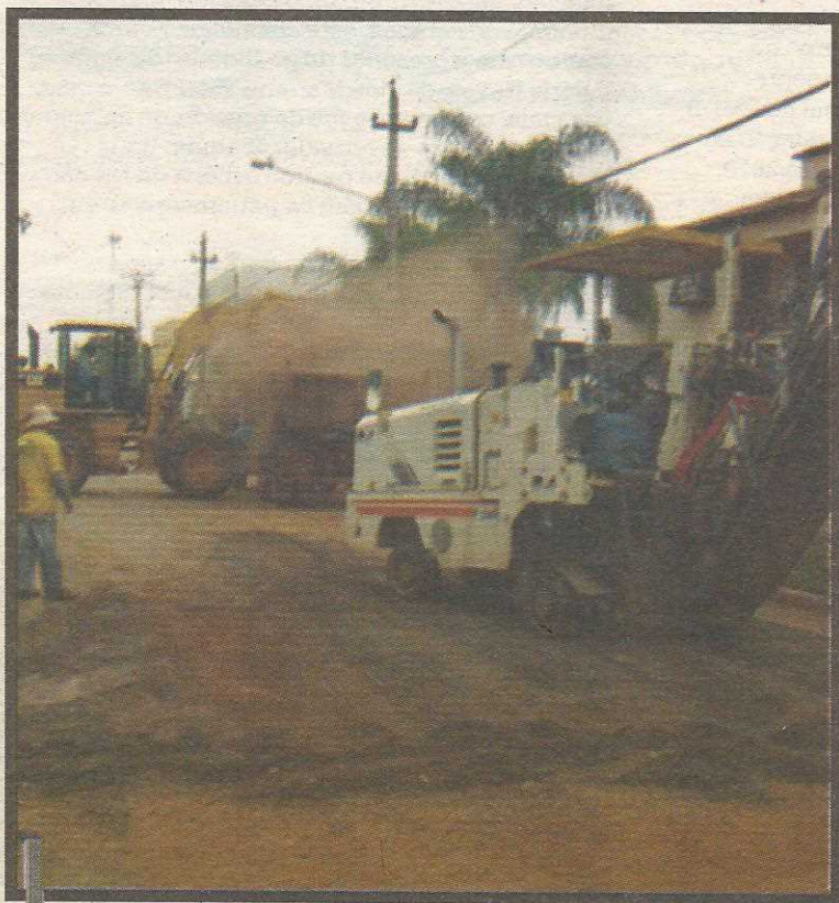
Cidade está sendo toda recapeada
