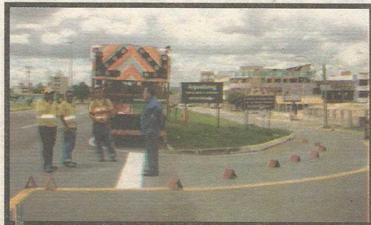
Serviço inclui todas as vias recapeadas na cidade
