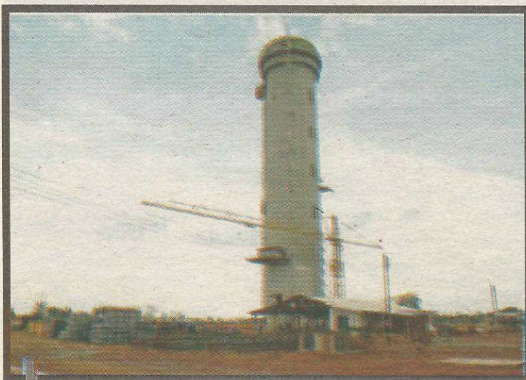
E a Torre Digital são grandes obras em andamento
