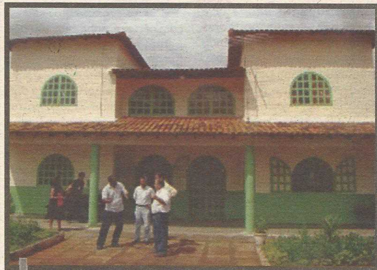
Sede da Gedes foi toda reformada
