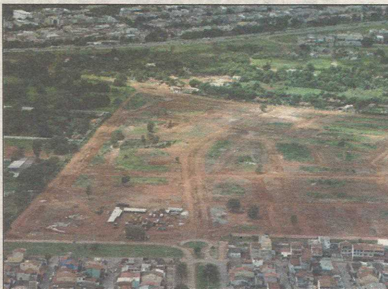
Ruas e instalações de água, esgoto e energia elétrica estão prontas à espera dos novos moradores
