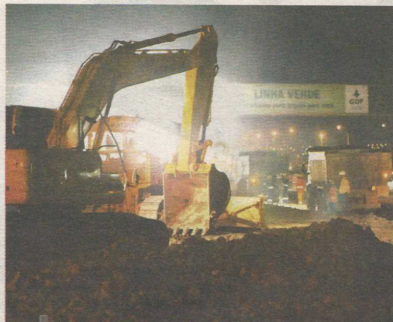
Operários têm trabalhado inclusive à noite para que a obra seja entregue no prazo previsto
