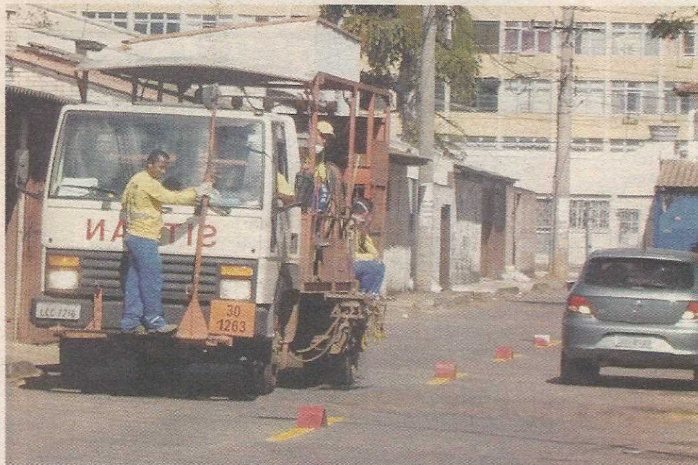
Asfalto recapeado recebe demarcação
