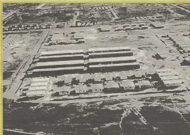
Início da instalação da rede elétrica, na QI
