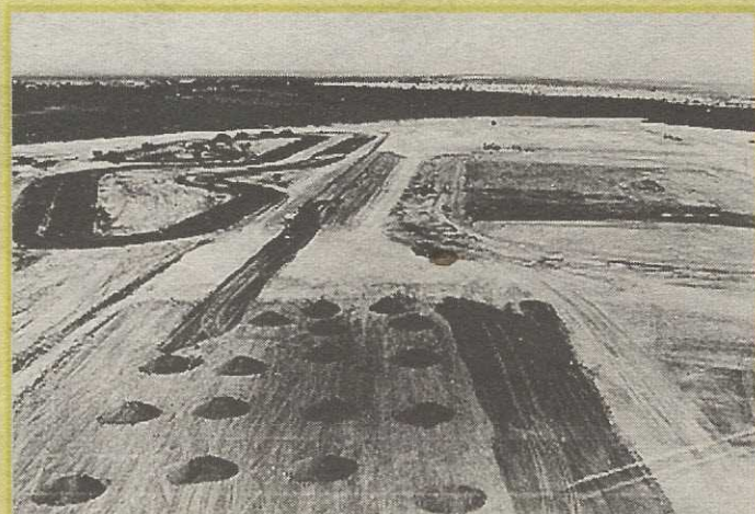
Início da construção do Guar II
