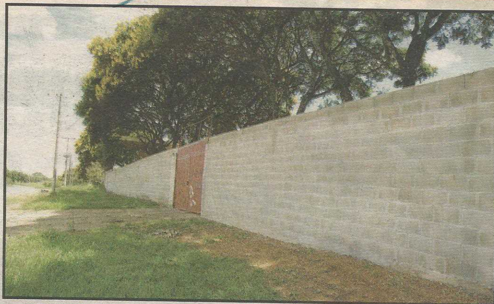
Estádio está recebendo muro novo. Outras reformas, só em 2011
