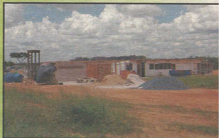
Heliporto está sendo construído ao lado o BPM
