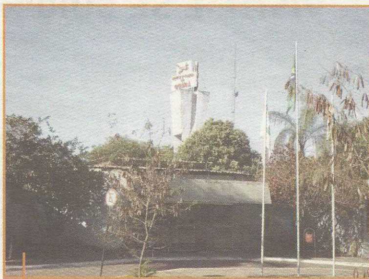
Estrutura da Administração do Guará melhora em relação à existente
