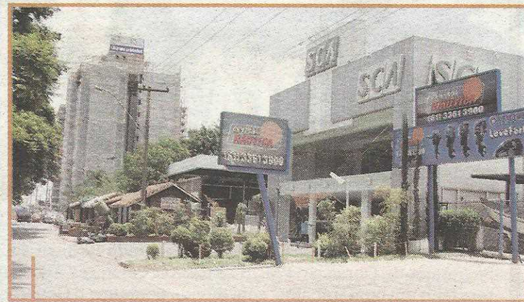
Lojas em área pública impedem o início das obras
