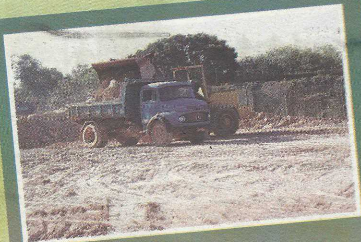
Canteiros de obras
