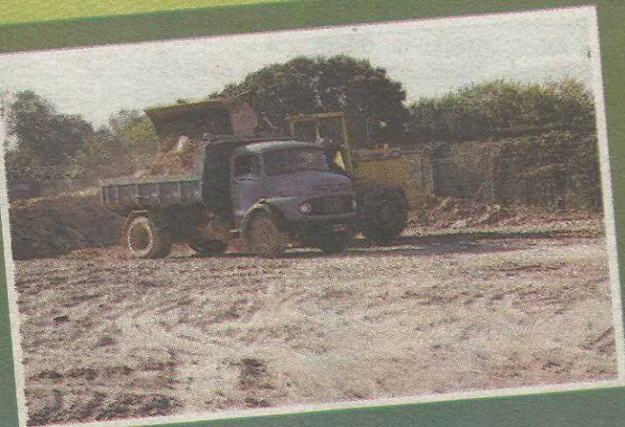
Canteiros de obras
