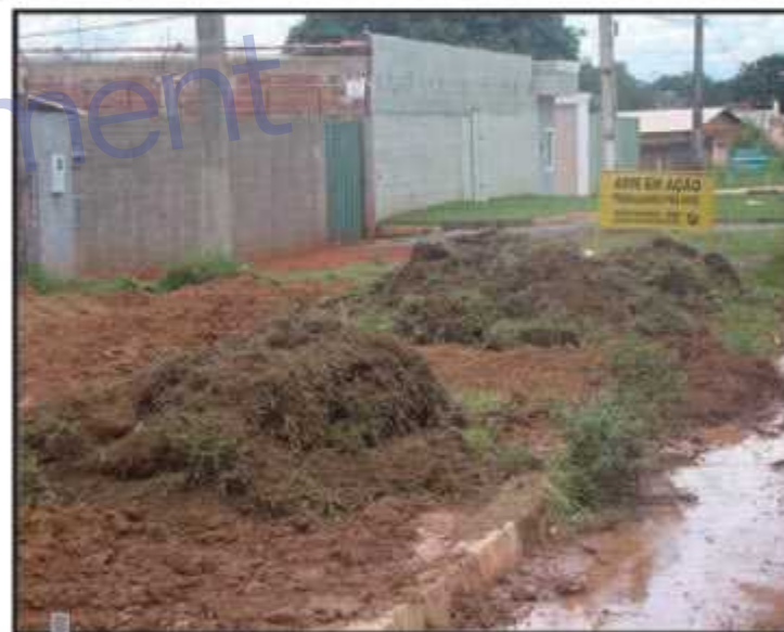
Ampliação de rede de captação de águas pluviais e calçadas são algumas das obras em andamento
