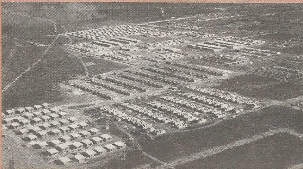
O mutirão começou construindo a OE/QI 5 e depois a OE/QI 3
