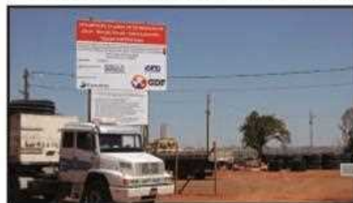
As obras de ampliação da rede do Guará continuam
