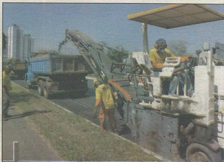
Recapeamento será concluído até o final de setembro, antes do início das chuvas
