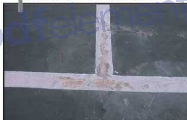
Pintura das quadras soltou-se dois dias depois de ser aplicada
