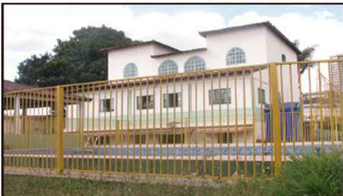
Sem uso, as instalações da Casa das Pedras estão se deteriorando, mesmo com a presença de cerca de 10 servidores lotados no espaço
