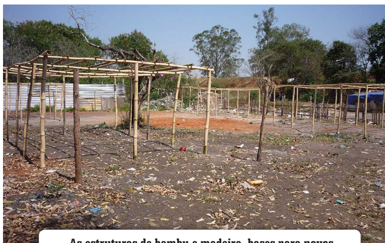
As estruturas de bambu e madeira, bases para novos barracos, mostram que em breve mais pessoas se mudariam para a Reserva Biológica do Guará.
