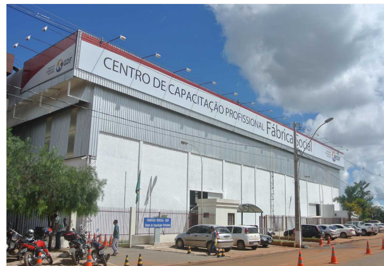
A Fábrica Social, instalada ao lado da cidade Estrutural, gera renda e capacitação para mais de 1200 famílias.
