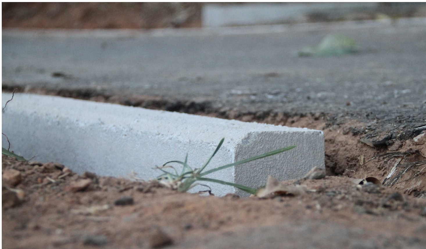
Meios-fios começam a ser colocados, mas a fina camada de asfalto preocupa os usuários. O administrador do Guará, Antonio Carlos Freitas, garante que a empresa cumprirá integralmente o que está previsto no projeto de licitação
