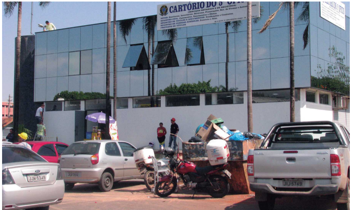
O novo cartório criou salas específicas para cada tipo de serviço. Localização e estacionamento facilitam o acesso dos usuários
