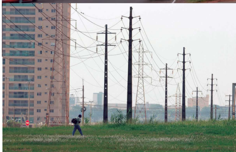
Rede de alta tensão no percurso será toda enterrada
