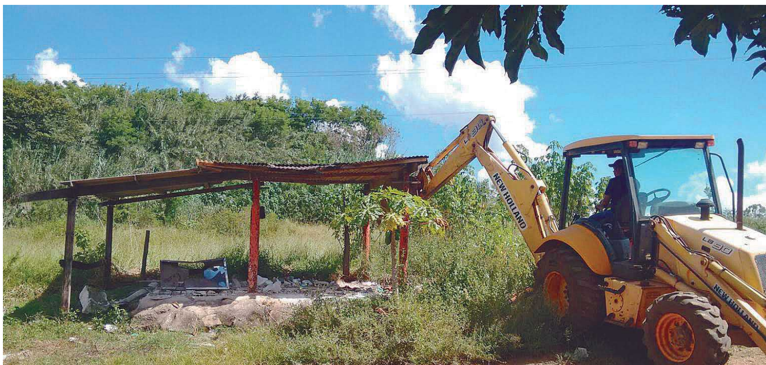
Todas as benfeitorias das chácaras serão demolidas
