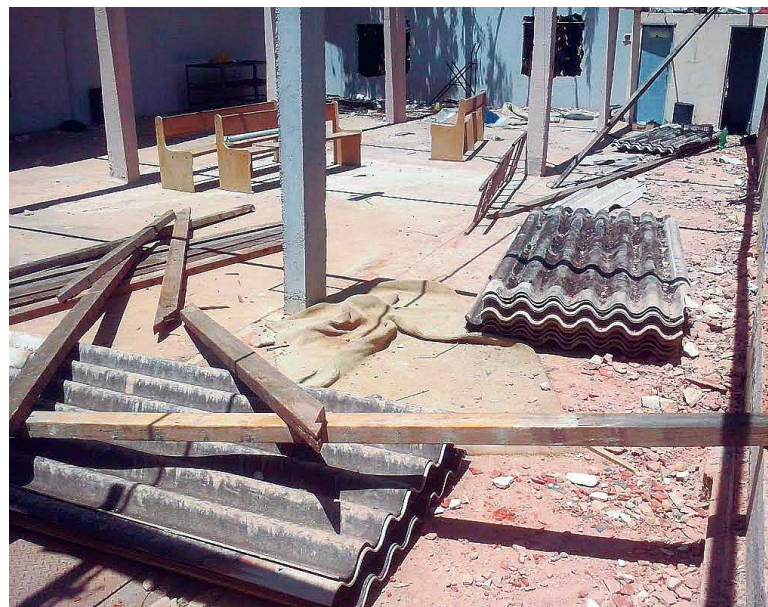
Foi demolida uma casa de 1.200 metros quadrados
