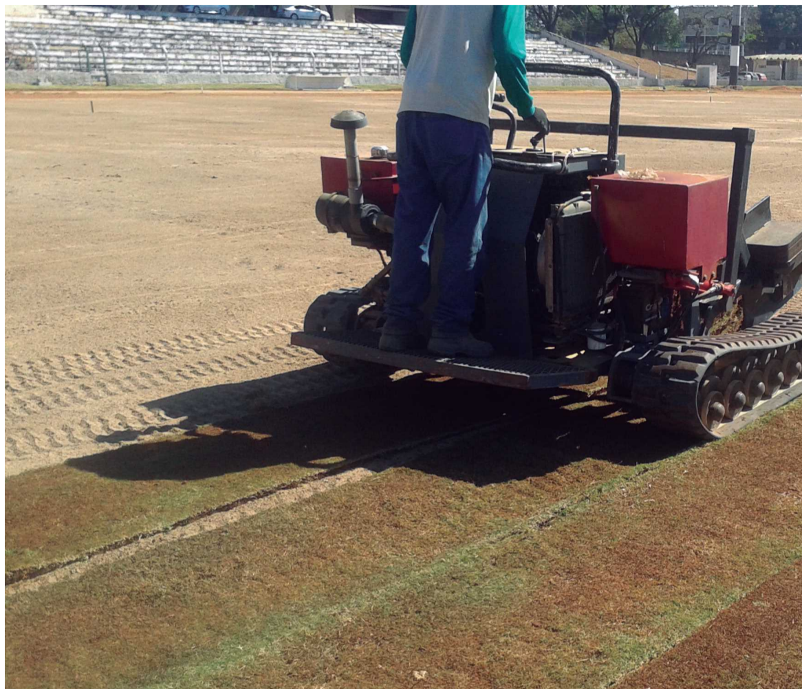
Gramado foi plantado em placas e poderá ser utilizado até 15 dias depois. A grama é a mesma do estádio Mané Garrincha, por recomendação da Fifa
