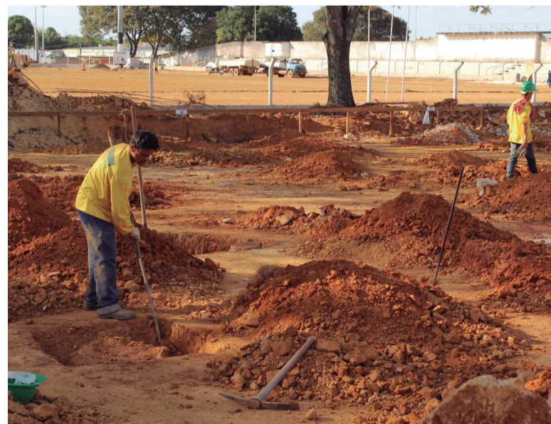
No lugar dos antigos vestiários, totalmente demolidos, estão sendo construídos vestiários modernos
