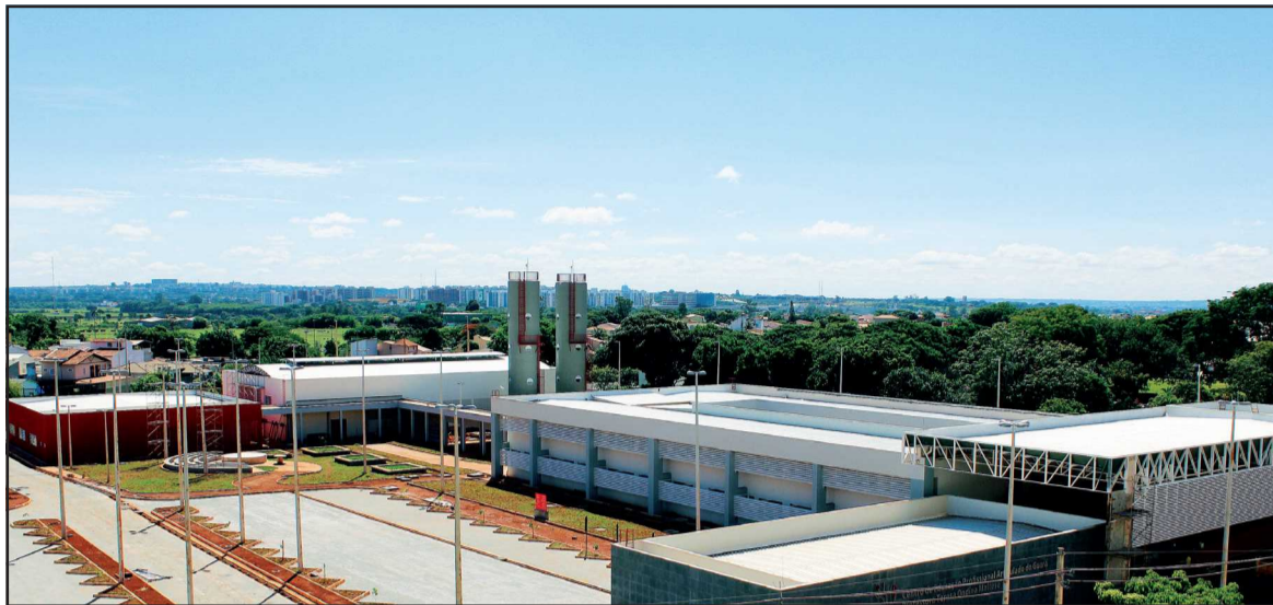
Prédio da Escola Técnica está praticamente pronto. Aulas já começam no segundo semestre
