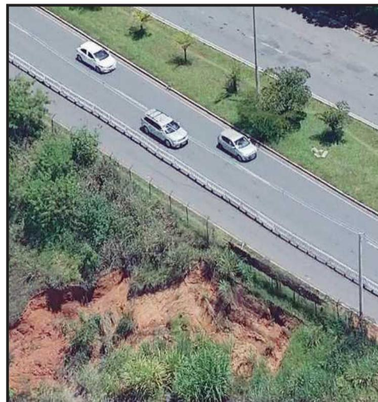
Erosão no córrego Guará que provocou rachadura e ameaça de desmoronamento na via EPGU tinha sido alertada em 2010
