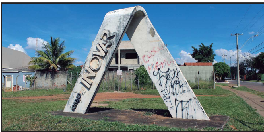
Da intenção do projeto original, ficou apenas a placa. À direita, reportagem do Jornal do Guará de junho de 2000, mostrando o lançamento da obra
