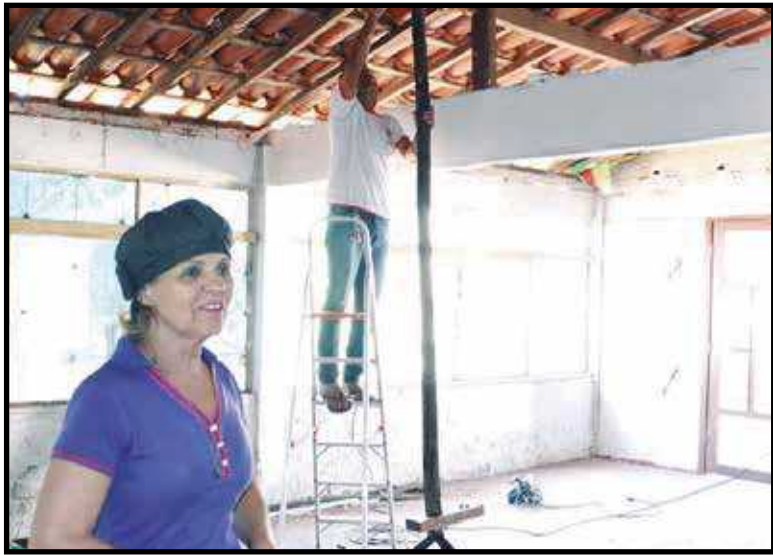
Voluntários, como Janete das Graças, promove a recuperação da antiga Casa da Cultura. Até as vigas que sustentam o telhado são reparadas de forma amadora, com anuência da Administração
