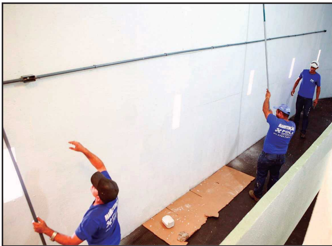
Obras começam pela pintura da parte interna
