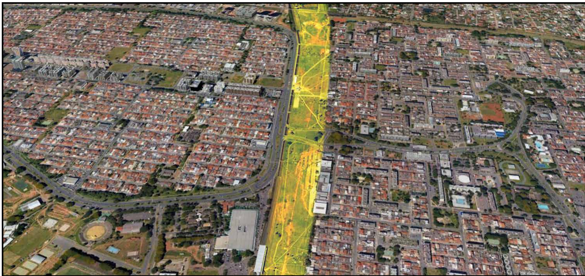
Região central do Guará sofrerá mudanças importantes com a construção da Interbairros. Lotes comerciais e residenciais irão surgir ao longo da via, onde hoje está a linha de alta tensão de Furnas
