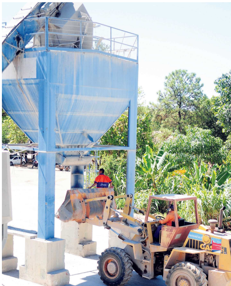
5 mil toneladas de asfalto foram produzidas em janeiro
