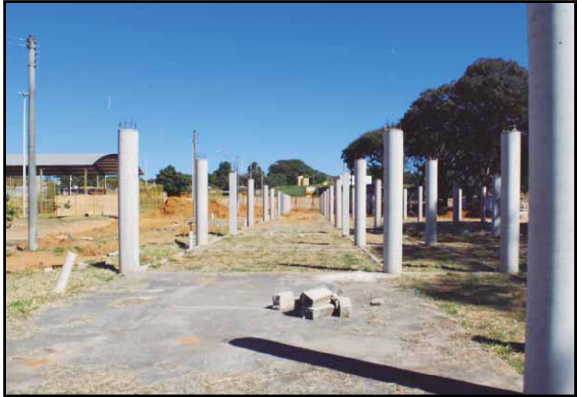
Já foram gastos cerca de R$ 800 mil na estrutura do vestiários...
