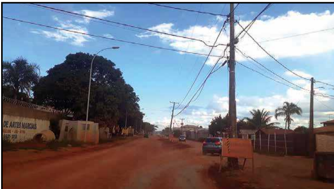
A duplicação da avenida é a principal queixa dos moradores, depois da demora da obra
