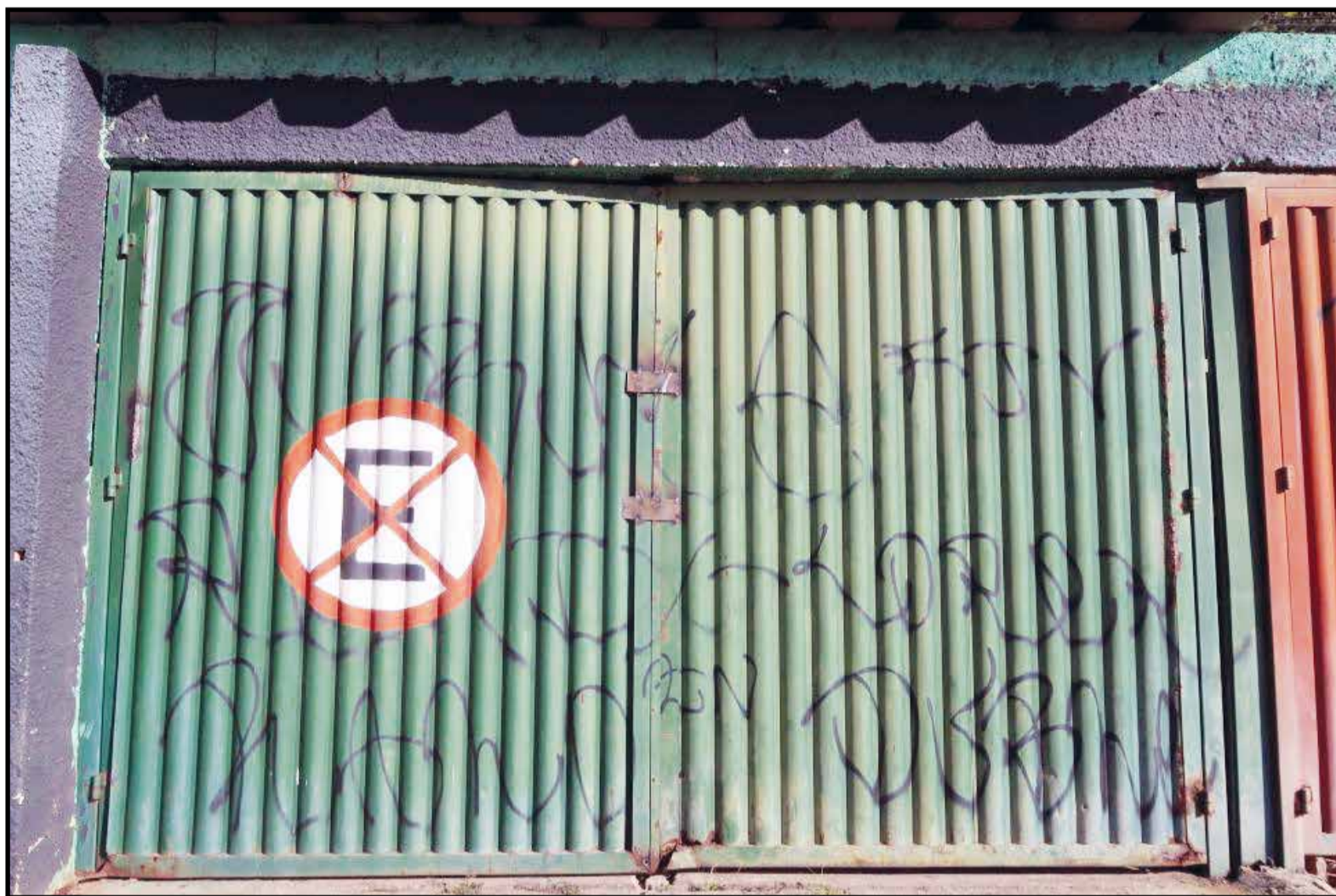
Portão principal de acesso ao kartódromo foi lacrado. Retirada de material será feito pelos fundos
