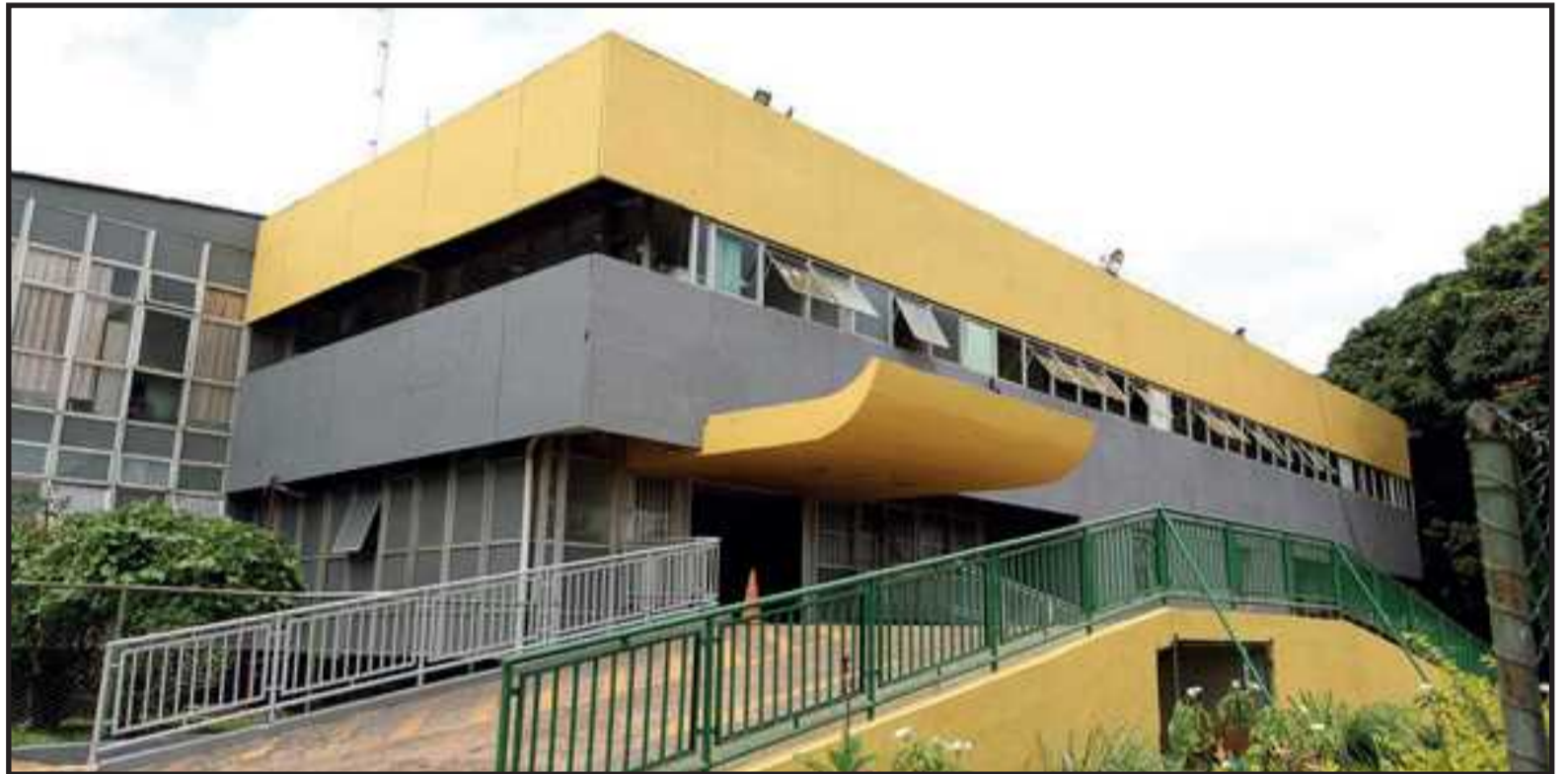
Ala pediátrica está sendo realocada para dar espaço à ampliação da emergência
